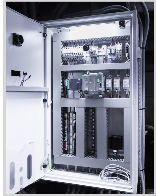
di cavi per portare il segnale; W2W Solutions ha invece ridisegnato il progetto intorno ad un unico bus di comunicazione, Modbus, riducendo così il cablaggio con un'ottimizzazione dal punto di vista dei costi e della leggerezza.
